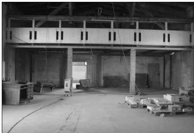
Die Empore im Inneren des Güterschuppens wurde wieder aufgebaut, die sie tragenden Schienen ruhen auf neu gemauerten Säulen.
