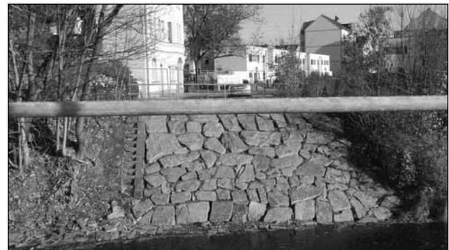
**Uferbefestigung nach dem Abriss der Brücke.**
